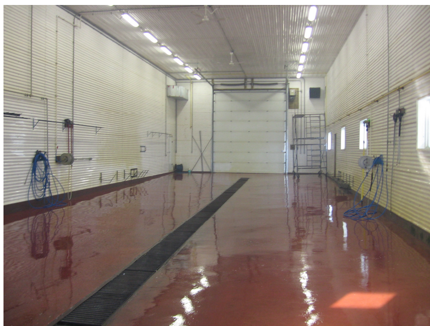
Figure A3.3 Vue intérieure d'une baie de lavage de Hytek
