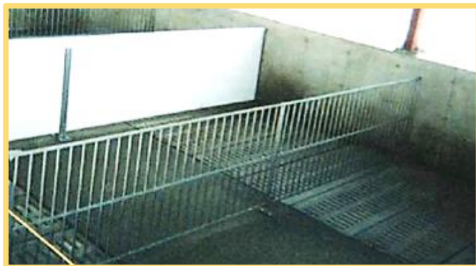
Plancher partiellement latté
