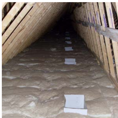
Figure 16 Entrée d'air modulaire sans filtre
