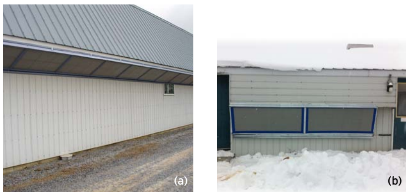
Figure 14 Filtres antimicrobiens de première génération (a) et de deuxième génération de type « rideau » (b)
